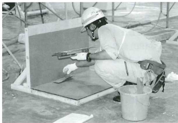
「ポリマーセメント防水工事」試験のよう
