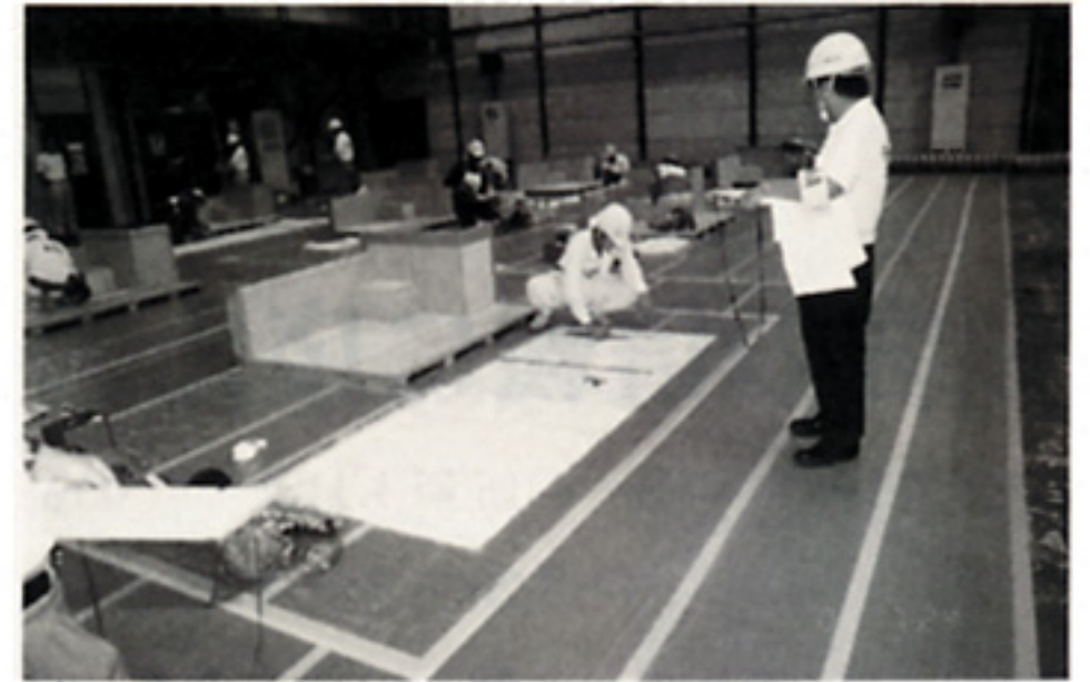
FRP防水実技試験のもよう
